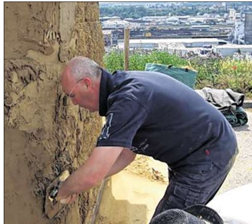
MIT LEHM VERPUTZT von einem Fachmann wie Paolo Scarpetta, werden dicke Wände aus Stroh tragender Bestandteil einer Konstruktion. Foto: pr
